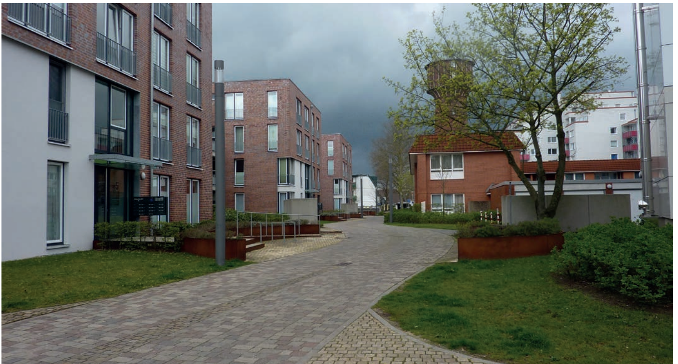
Abb. 88: Neuer Fußweg in einem Wohnquartier in Elmshorn
