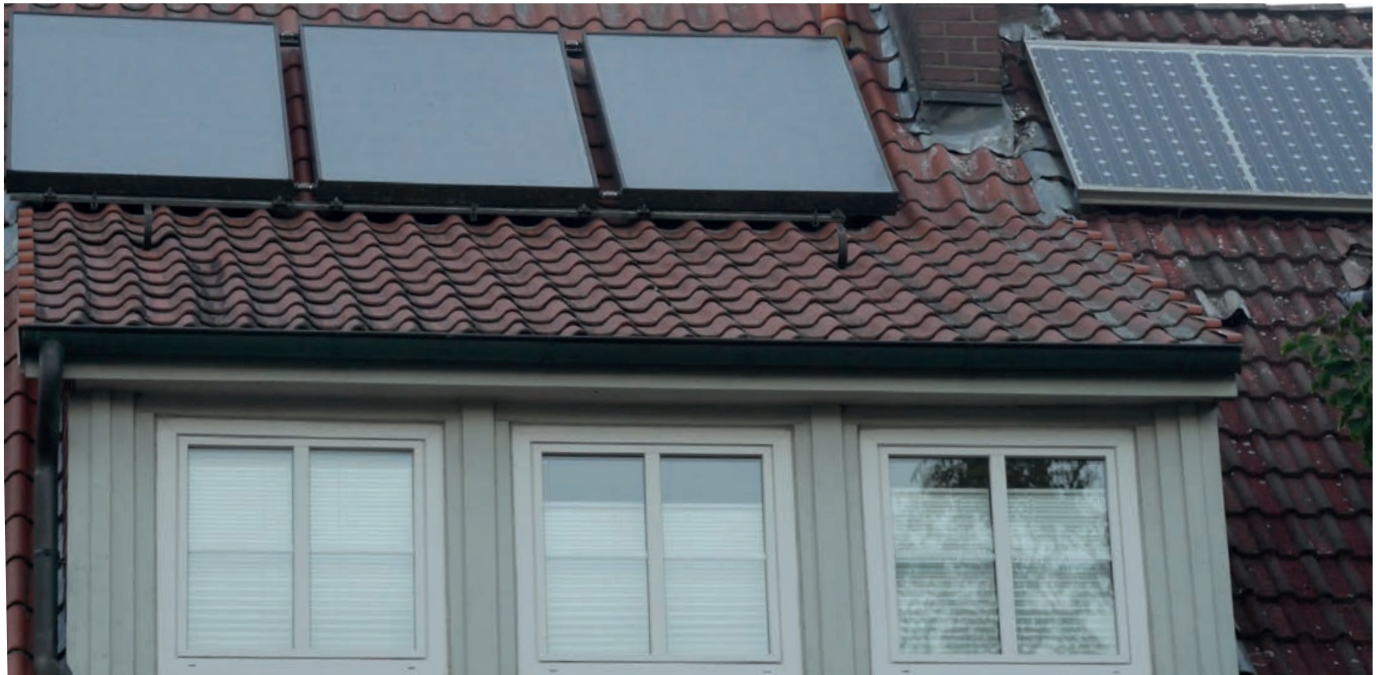
Abb. 77: Solarthermische Kollektoren
