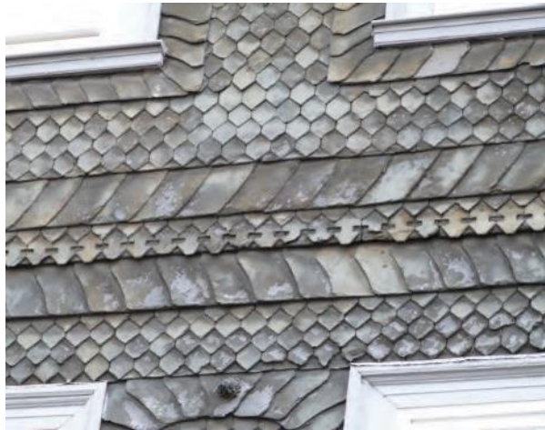
Abb. 52: Schieferschindeln an einer Hausfassade (rechts)
