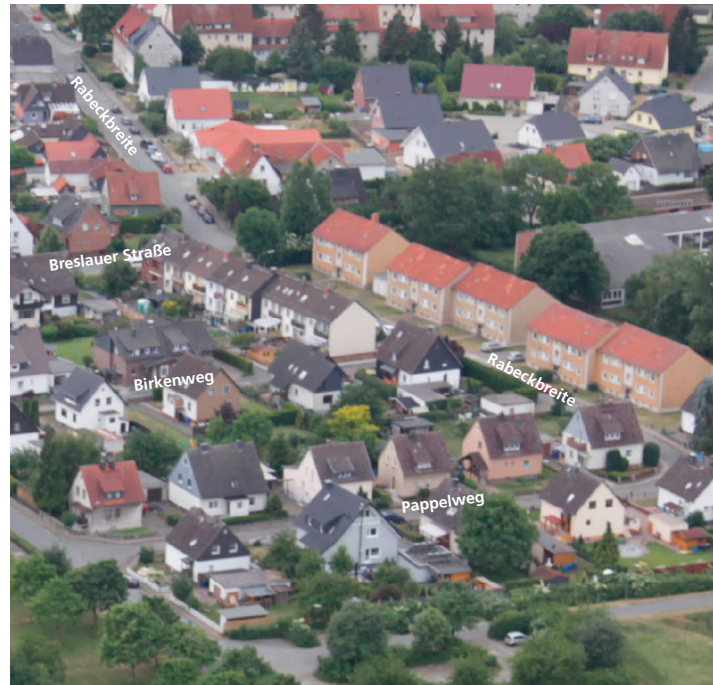
Abb. 4.5/1 Sanierungsbedarf im Bestand: Gebäude aus den 50er und 60er Jahren
