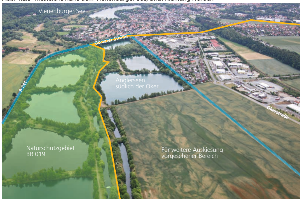
Abb. 4.2/5 Kiesteiche nahe dem Vienenburger See, Blick Richtung Norden
