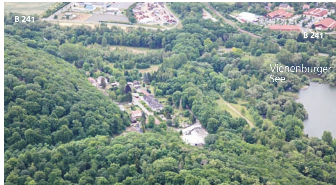
Abb. 4.1/14 Schacht I, Blick Richtung Osten
