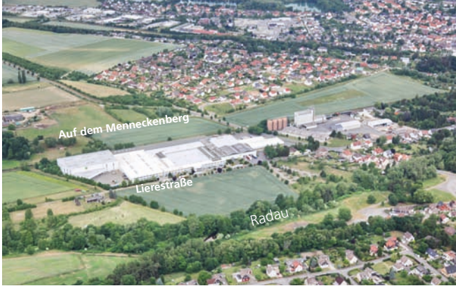
Abb. 4.1/10 GE Lierestraße, Blick Richtung Nordosten
