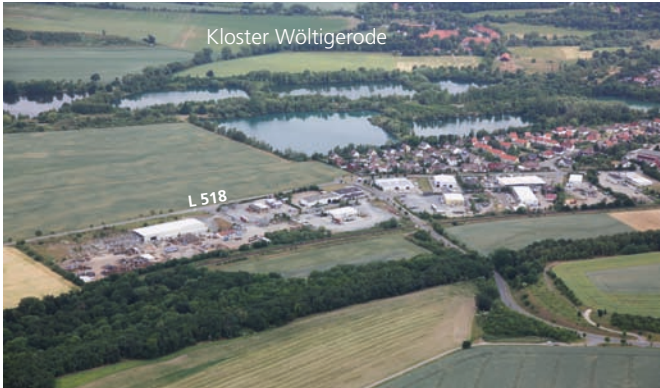
Abb. 4.1/11 GE Okerstraße, Blick Richtung Norden
