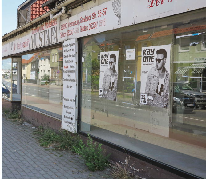
Abb. 4.5/2 Leerstehendes Ladengeschäft in der Goslarer Straße
