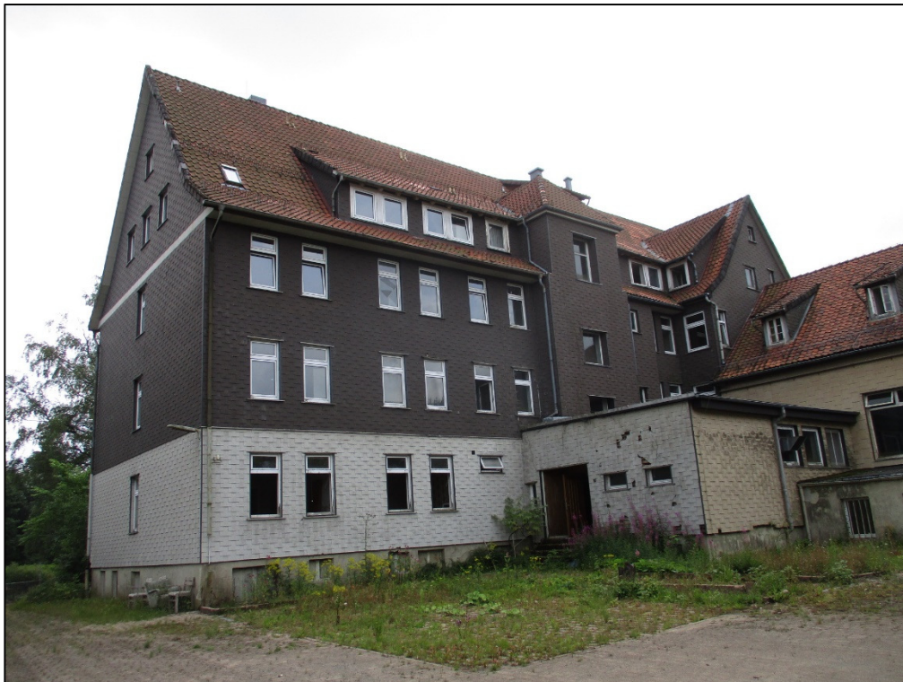
Abbildung 1: Bestandsgebäude östliches Baufeld, Blickrichtung Südwest
