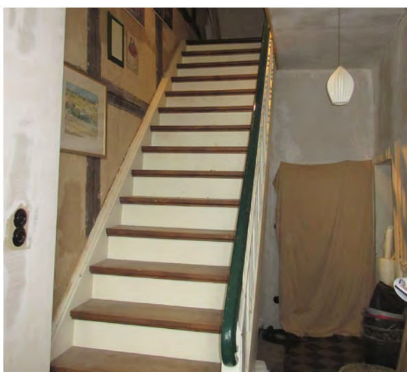
Bild 82 Arbeiten rund um das denkmalgeschützte Treppenhaus
