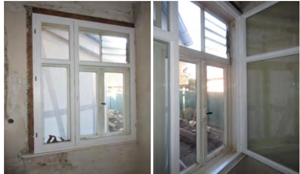
Bild 29 Nachrüsten eines Kastenfensters
