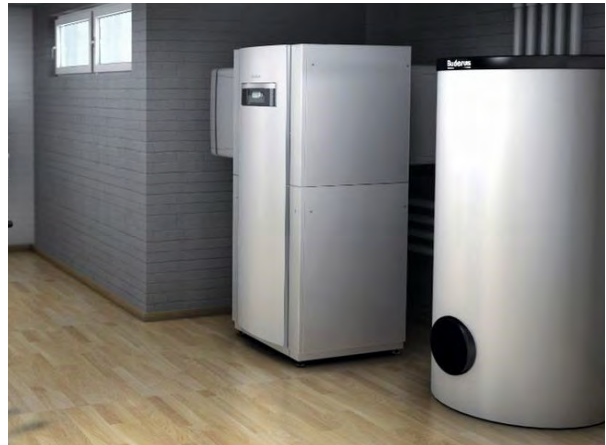
Bild 61 Einbausituation einer Außenluft-Wärmepumpe Luftansaugung über Außenwanddurchbruch
