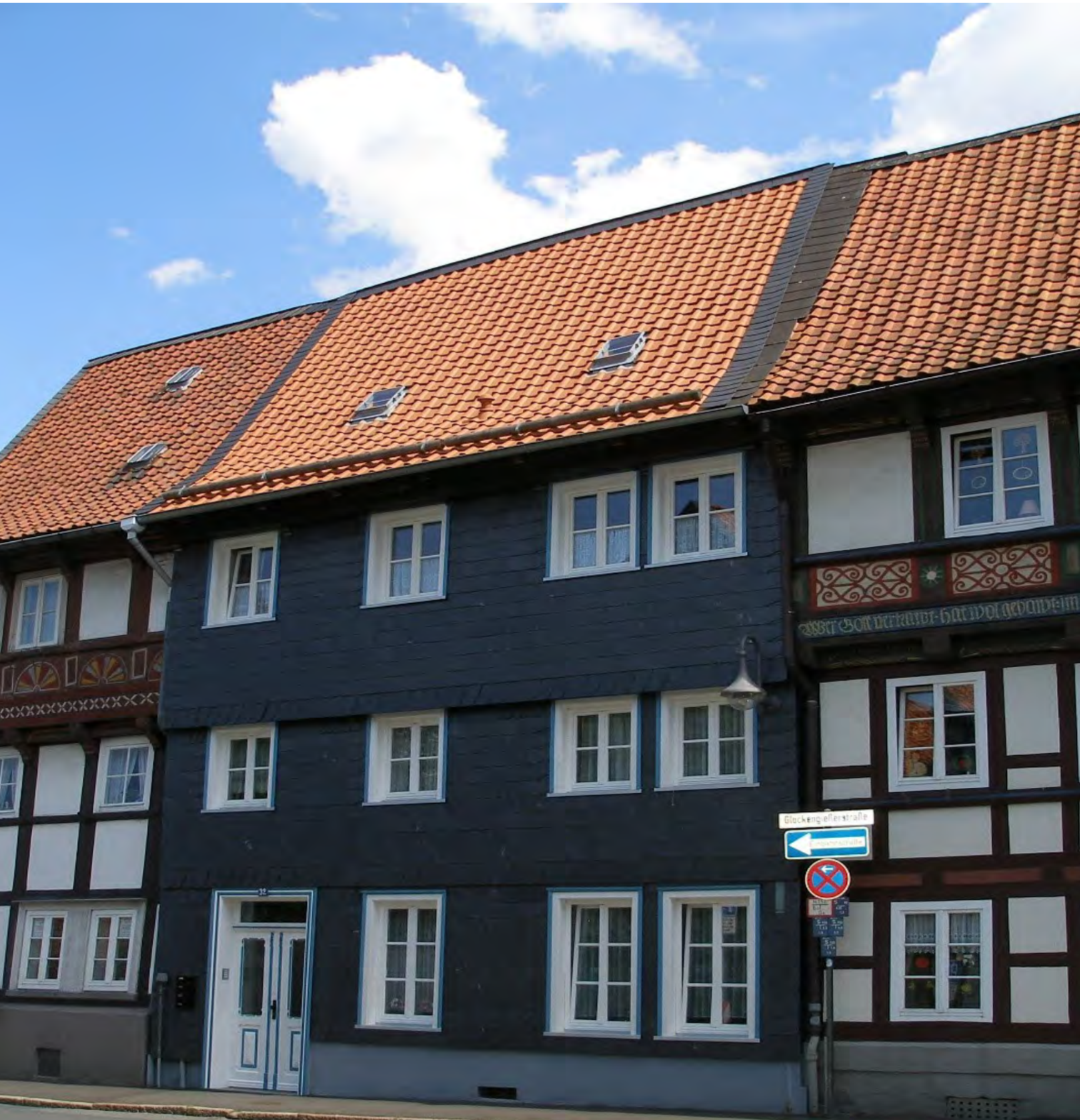
Bild 19 Problem: Verdeckung des Sichtfachwerks und Entstehung tiefer Fensterlaibungen durch die Außenwanddämmung
