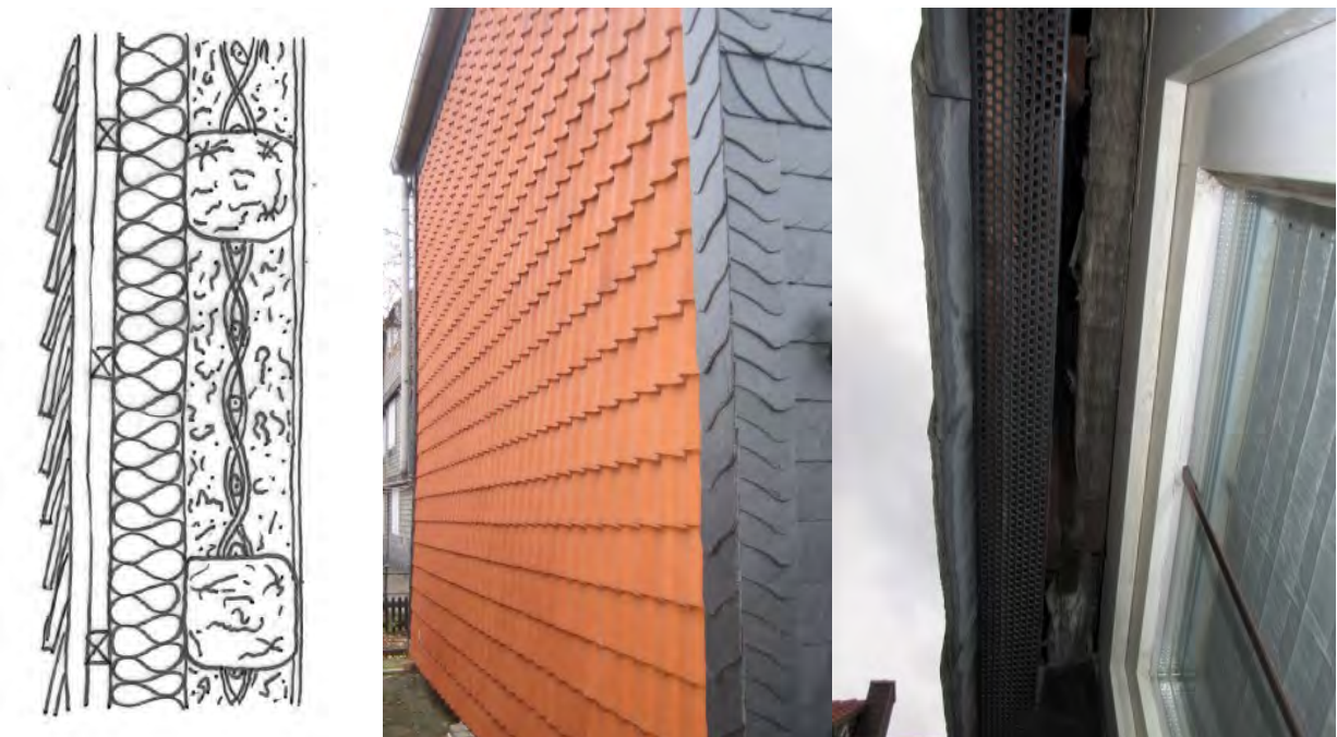
Bild 18 Beispiel: Außendämmung unter einer Schiefer- und Ziegelverkleidung
