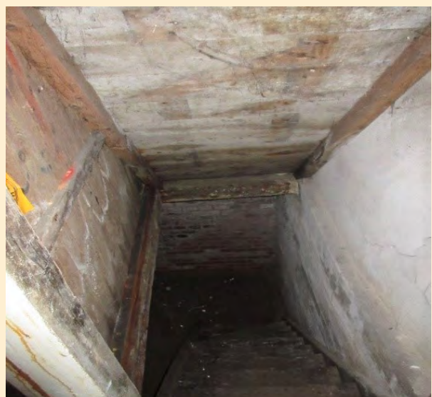
Bild 52 Ungedämmter Kellerabgang
