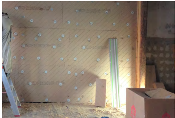
Bild 21 Anbringung einer Holzfasereinnendämmung
