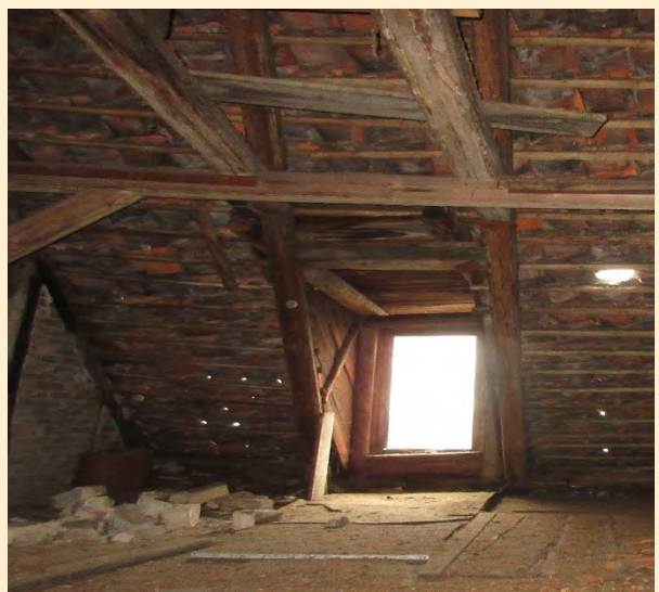
Bild 44 Typische Dachgauben von außen und innen
