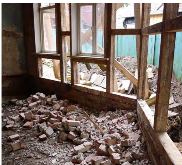
Bild 81 Kernsanierung des Anbaus aus den 30er Jahren
