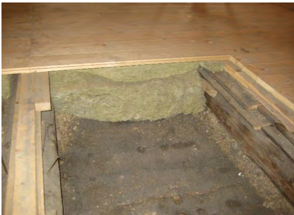
Bild 49 Dämmung in der Deckenkonstruktion mit Maten aus weichem Faserdämmstoff
