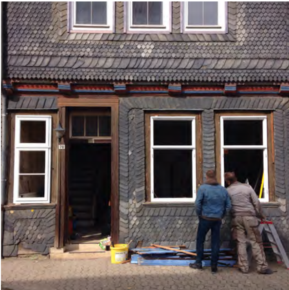
Bild 77 Instandsetzung der Fassade und Einbau neuer Fenster
