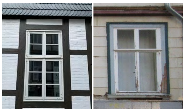
Bild 30 Vergleich saniertes und unsaniertes Fenster
