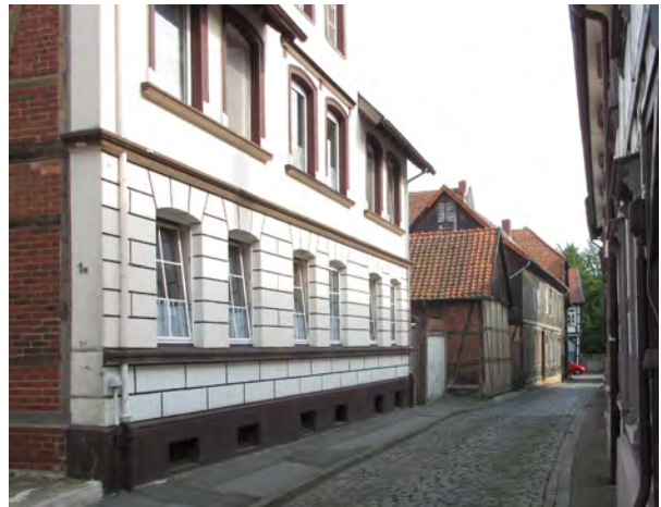
Bild 51 Gebäudefront mit Kellerfenstern im Sockel
