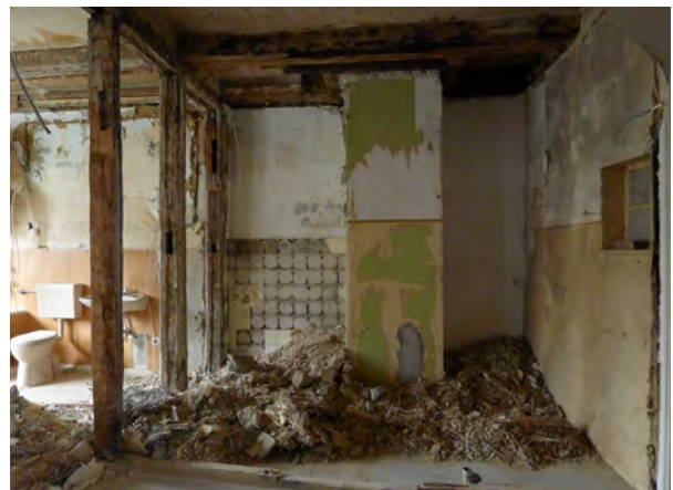
Bild 80 Abriss und Entkernung im 1. OG (zukünftiger Raum: Wohnküche)
