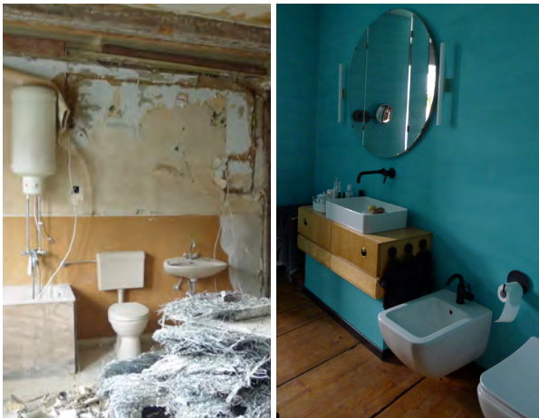
Bild 79 Renovierung Badezimmer mit Freilegung der historischen Dielen
