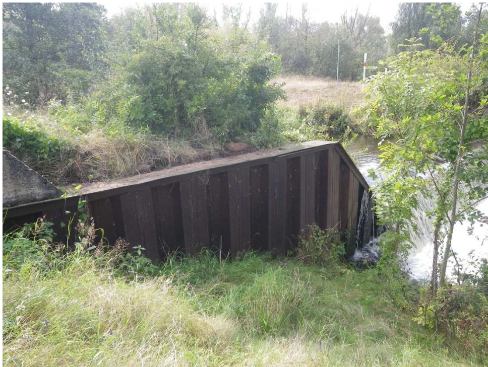
Abbildung 2: Stahlspundbohlenprofileinbindung in Böschungen
